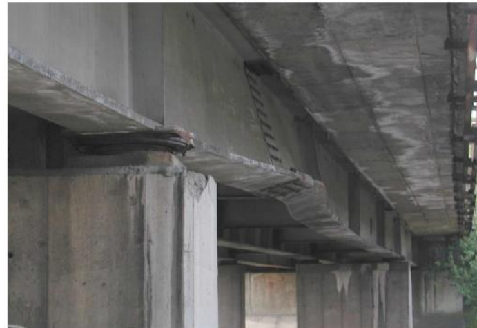
Most Vráž po nárazu vozidla
