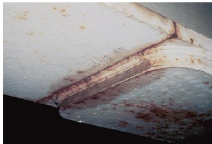
Změna průřezu pásnice
