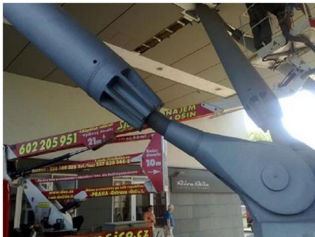
Podpření bytového domu, Holešovice
