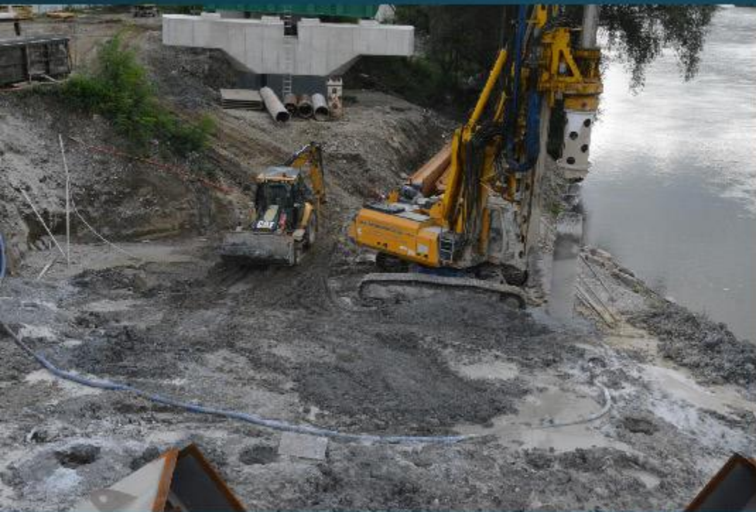
provádění předvrtů
