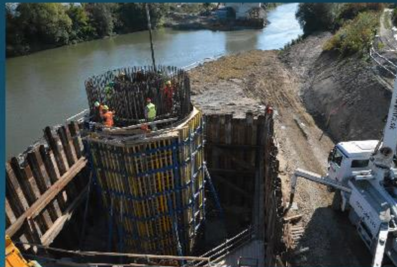
Betonáž dřáku pilíře P4
