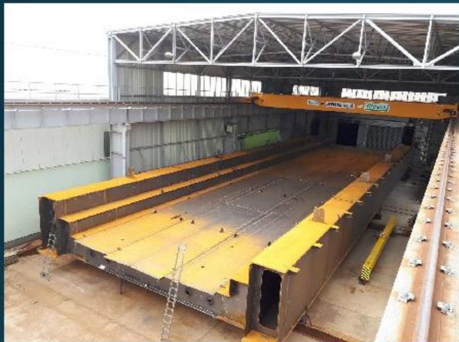
Dílenská přejímka část obloukového mostu
