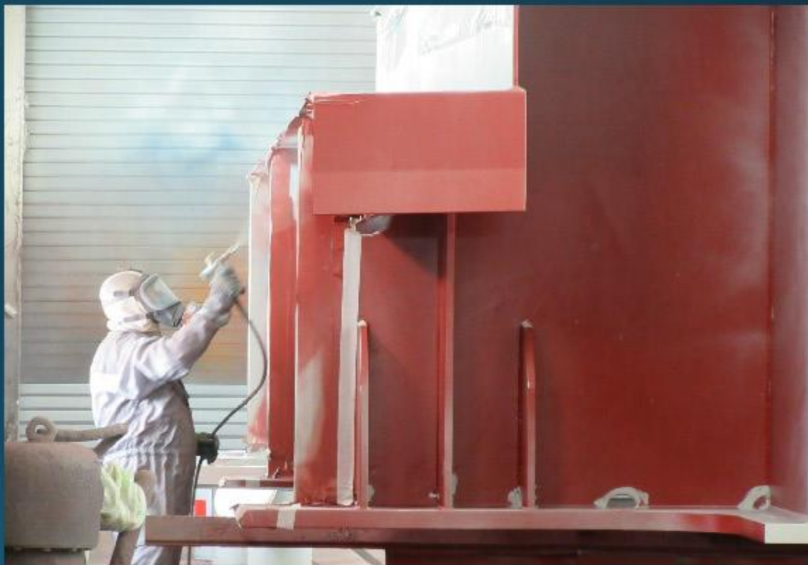
Aplikace protikoroziční ochrany
