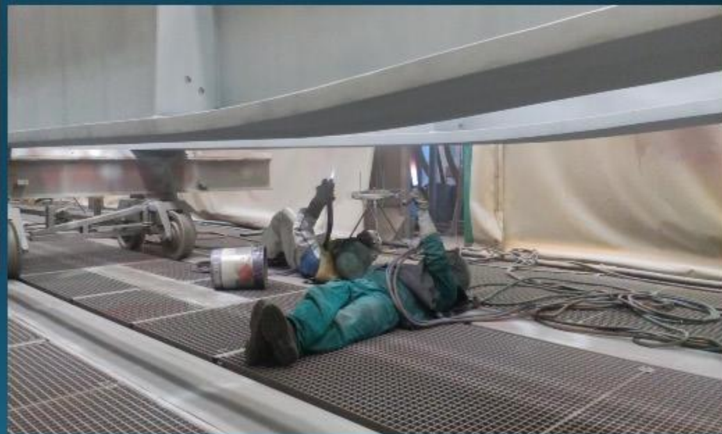
Aplikace protikoroziční ochrany
