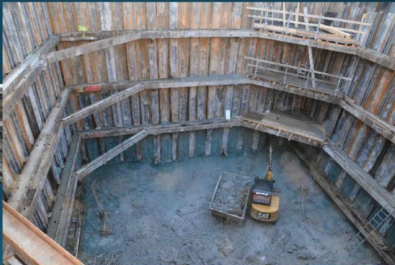
výkop pažené stavební jámy
