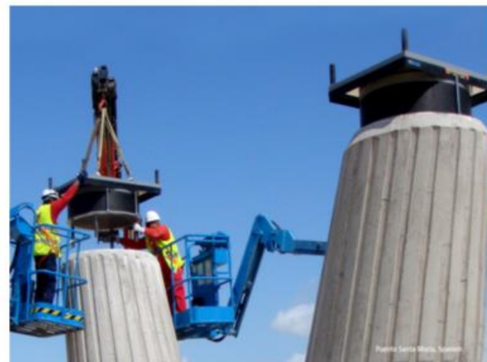
Príklad osadenia všesmerných elastomerových ložísk
