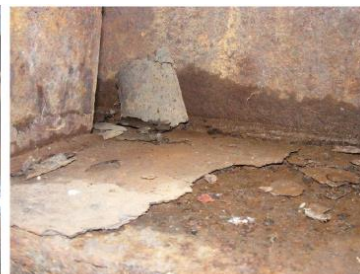
(b) Vrstevnaté korozní produkty na horním povrchu dolní pásnice mostní konstrukce vytvořené v důsledku hromadění nečistot a zádrží vlhkosti
