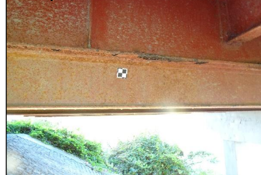
Most přes řeku Polanka
