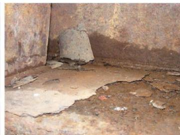
(b) Vrstevnaté korozní produkty na horním povrchu dolní pásnice mostní konstrukce vytvořené v důsledku hromadění nečistot a zadržní vlhkosti
