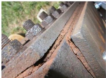
(a) Spárová koroze stožáru v místě příložkového spoje nárožníku
